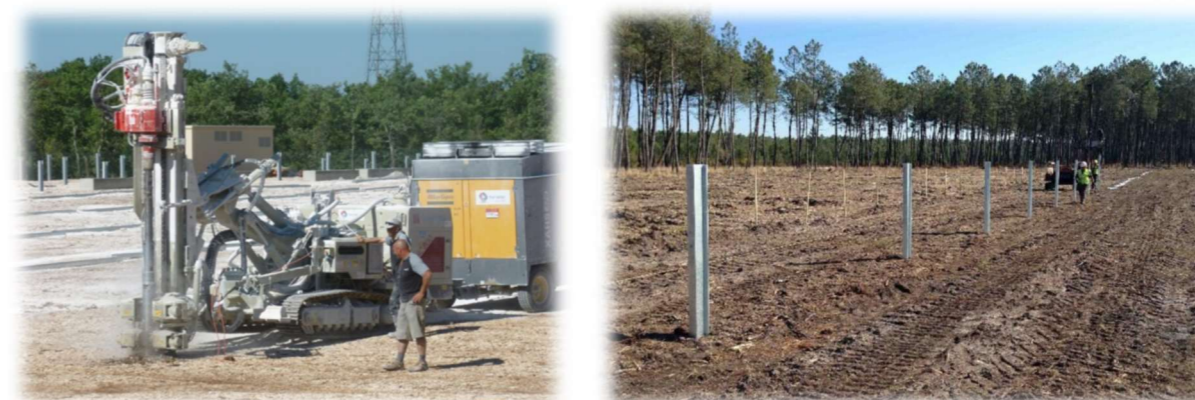
Ancrage au sol par pieux battus
